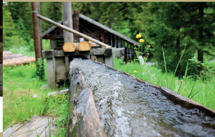
Die gut erhaltenen Holzrinnen befördern das Wasser immer noch wie damals direkt in die Säge.
